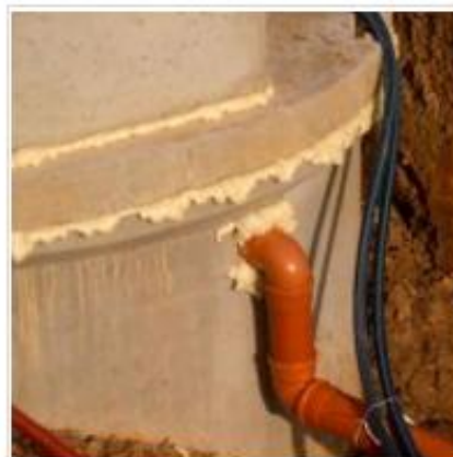
Obr. 11 - Utěsnění trubky u bet. nádrže
