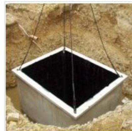
Obr. 12 - Usazení betonové nádrže
